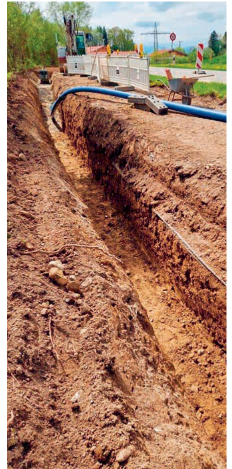
Sanierung der Wasserleitung im Zuge des Radwegneubaus in Almertsham, Gemeinde Höslwang
